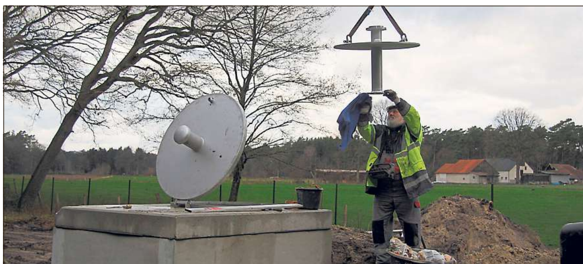
Die Arbeiten an einem neuen Brunnen der Vereinigten Gas- und Wasserversorgung im Mühlgrund stehen vor dem Abschluss. Bilder: Ackfeld
