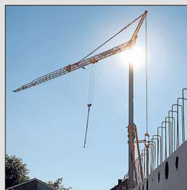
Der Blick aus der Tiefgarage. Bald kommt die Decke darauf.
