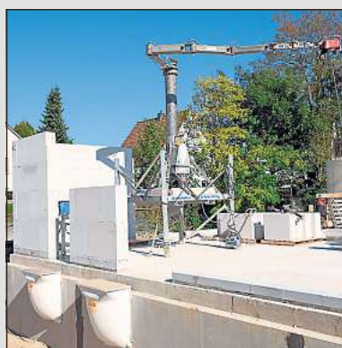
Die ersten Steine für die Wohnhäuser sind bereits gesetzt.
