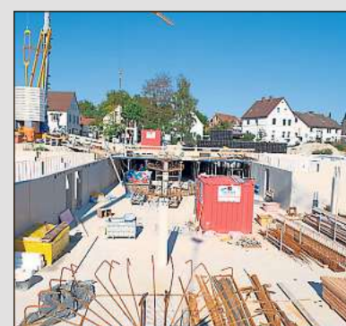
400 Tonnen Stahl werden auf dem gesamten Areal verbaut.
